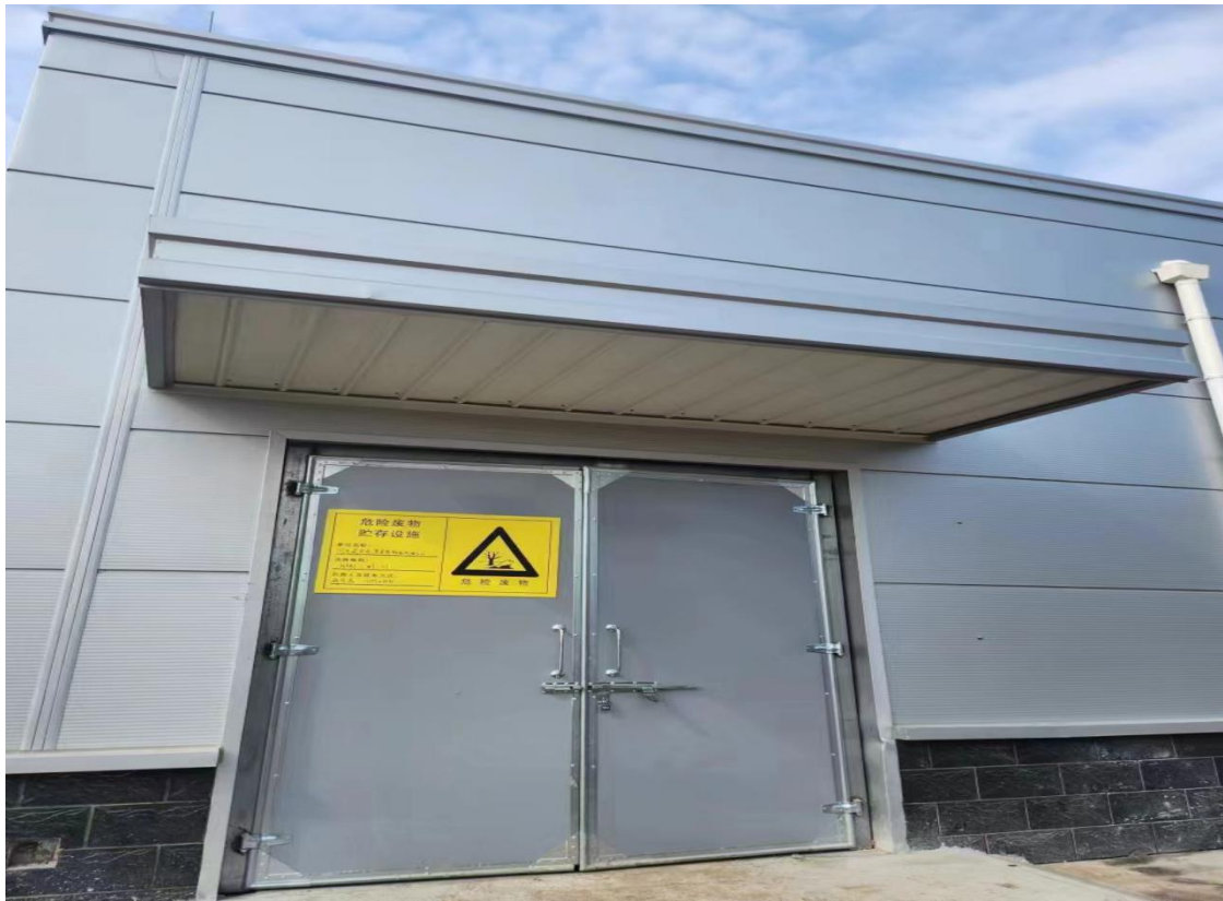
危险废物暂存间
